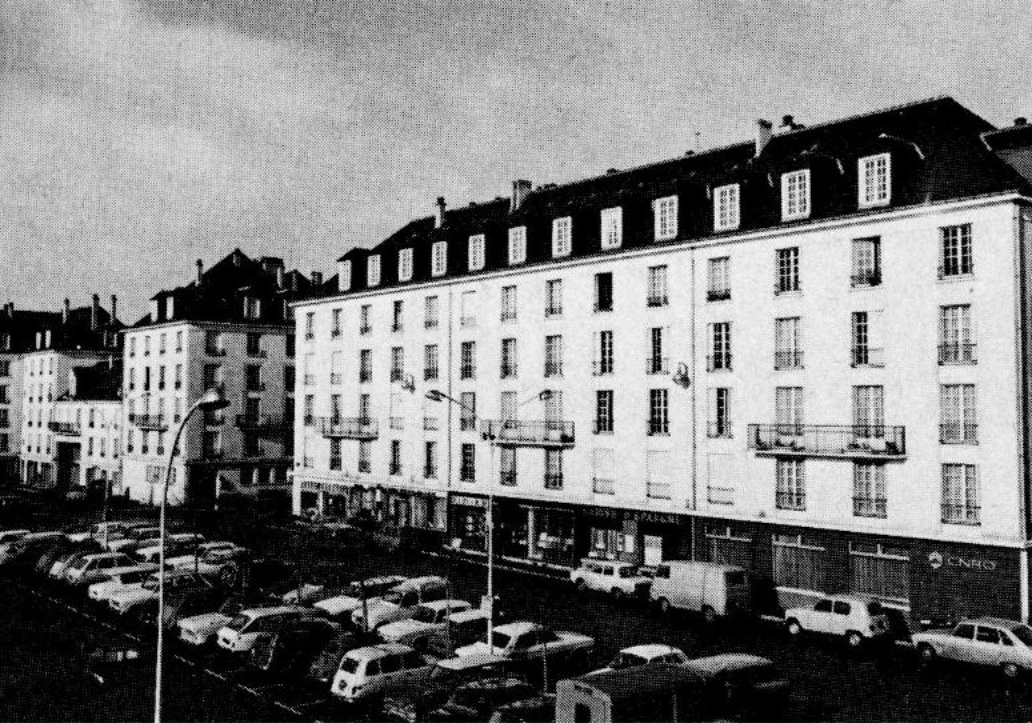
Un exemple de la rénovation, le front nord de la place des Halles. (R. Arsicaud & Fils.)
